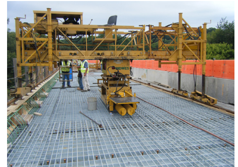
Screed Check before Pour
